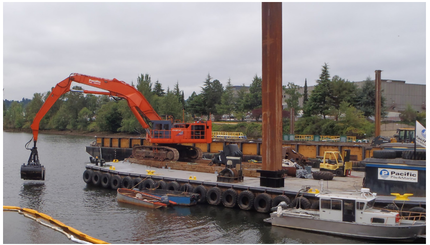
Máy nạo vét thủy lực loại bỏ trầm tích bị ô nhiễm khỏi đáy sông.
